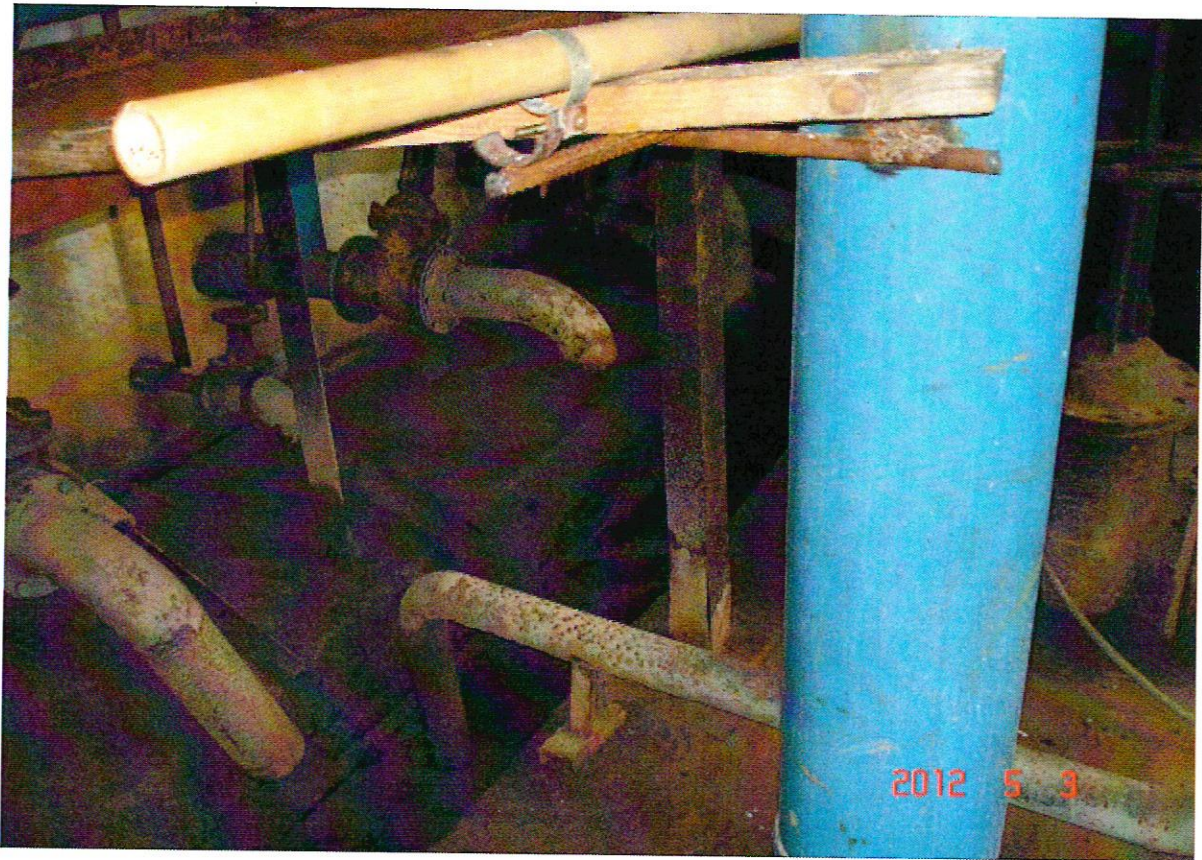
Состояние трубопроводов и запорной арматуры.
