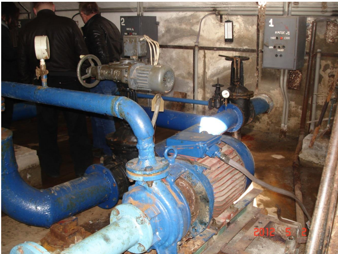
Рисунок 24 Состояние трубопроводов и насосов.
