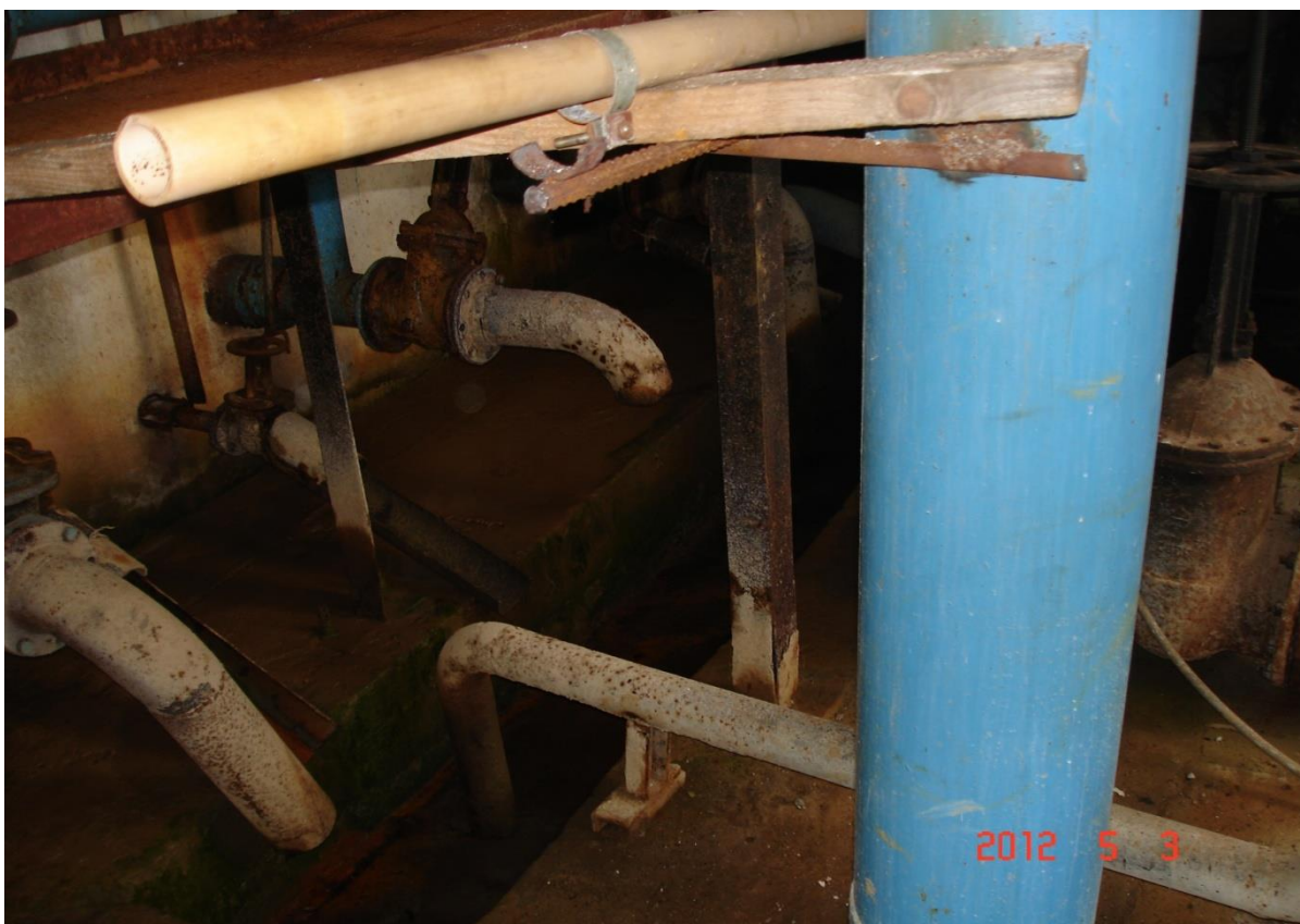
Рисунок 24 Состояние трубопроводов и насосов.
