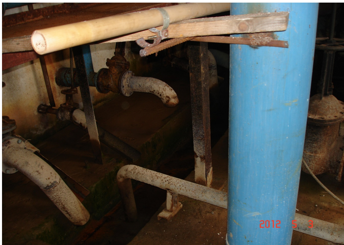
Состояние трубопроводов и запорной арматуры.
