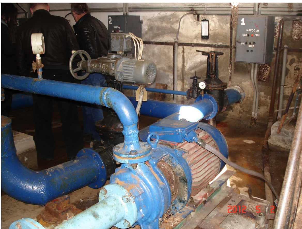
Состояние трубопроводов и насосов.
