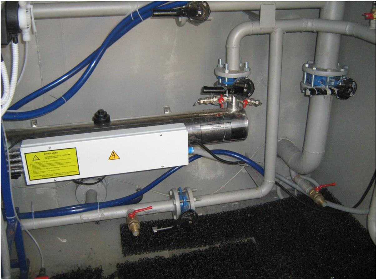
УФ обеззараживатель. Установка для обеззараживания очищенной воды.
